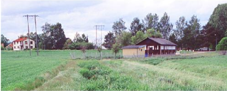
Typfall 1 "Det gamla reningsverket på landet"
