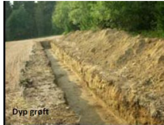
Dyp grøft med fordelingslag og inf.rør
